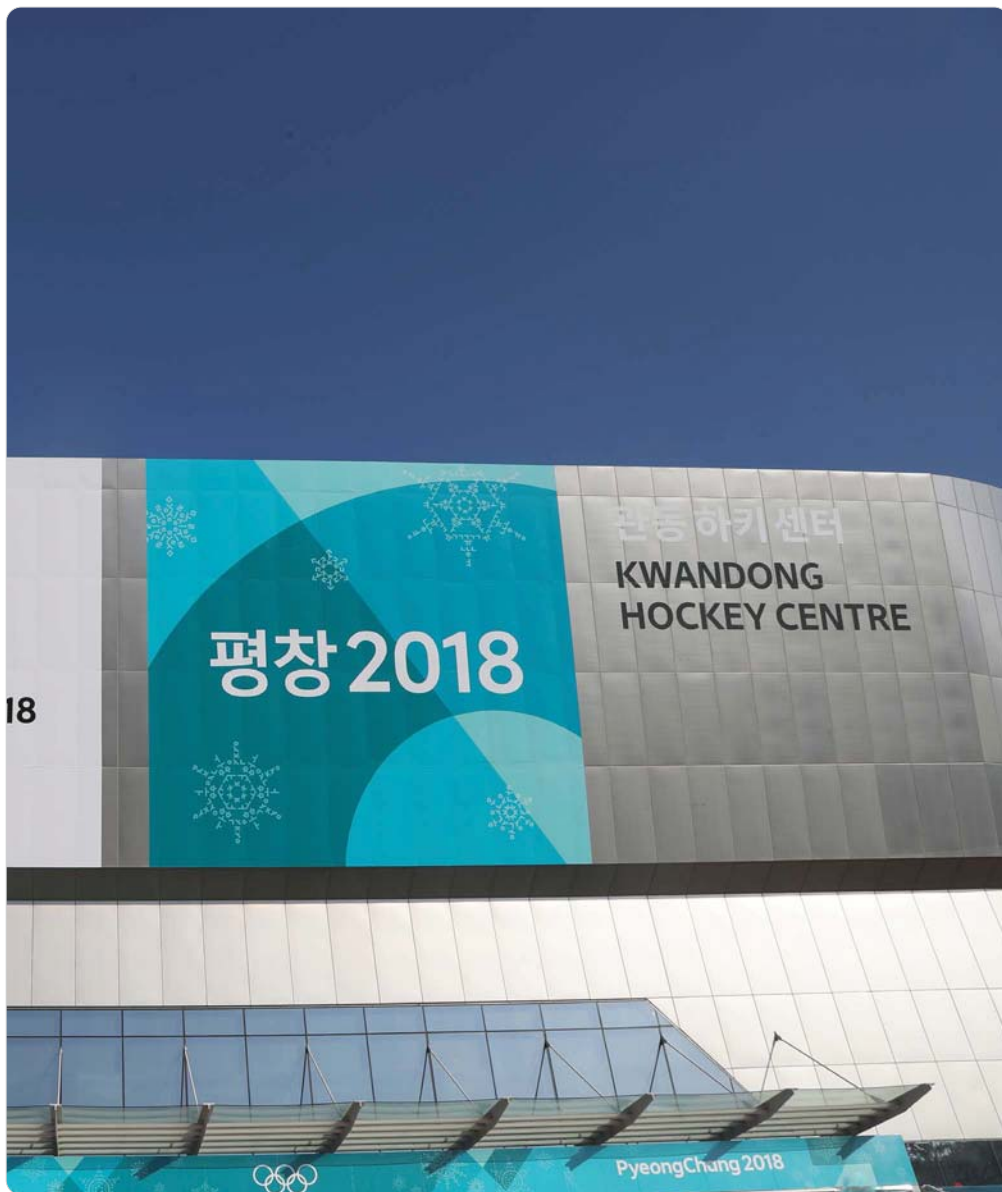
韩国关东冰球中心细节图，使用精益双相不锈钢 329LD 包覆
