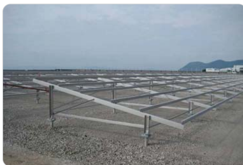
双相不锈钢SUS821L1制作的太阳能电池板支架
