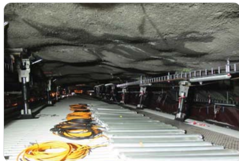
霍尔默斯特兰地铁隧道的动态吊架 供图：桑德维克材料技术公司
