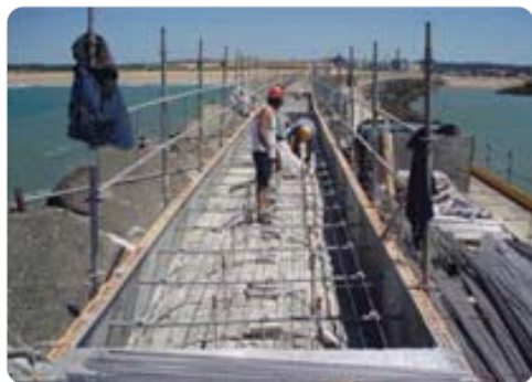
法国巴约讷市防波堤 供图: 尤基泰克公司
