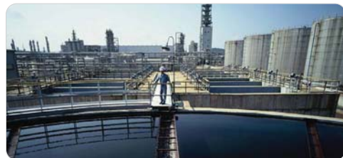
废水处理厂 供图: 腐蚀研究所
